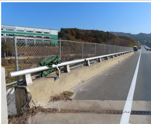
방호벽 및 난간 전경
